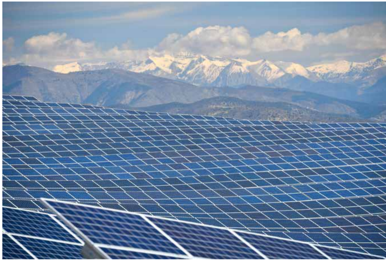
Des panneaux solaires photovoltaïques de la centrale électrique de La Colle des Mees, dans les Alpes-de-Haute-Provence.
